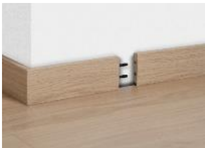
Verbindung von 2 Sockelleisten entlang der Wand
